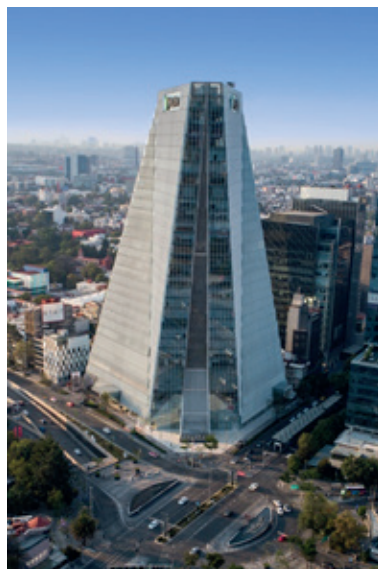
Figura 17 Guillermo Soto, Conjunto Manacar, Fotografía con Dron
