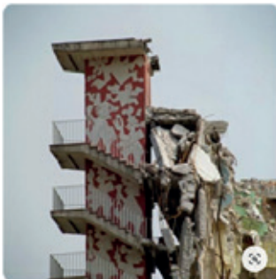
Figura 6 Bob Schalkwijk. Demolición del Centro Urbano Presidente Juárez, 1985.
