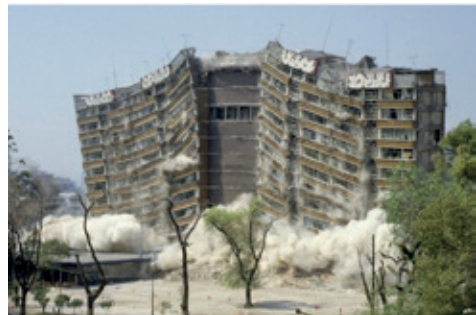
Figura 7 Bob Schalkwijk. Demolición del Centro Urbano Presidente Juárez, 1985.
