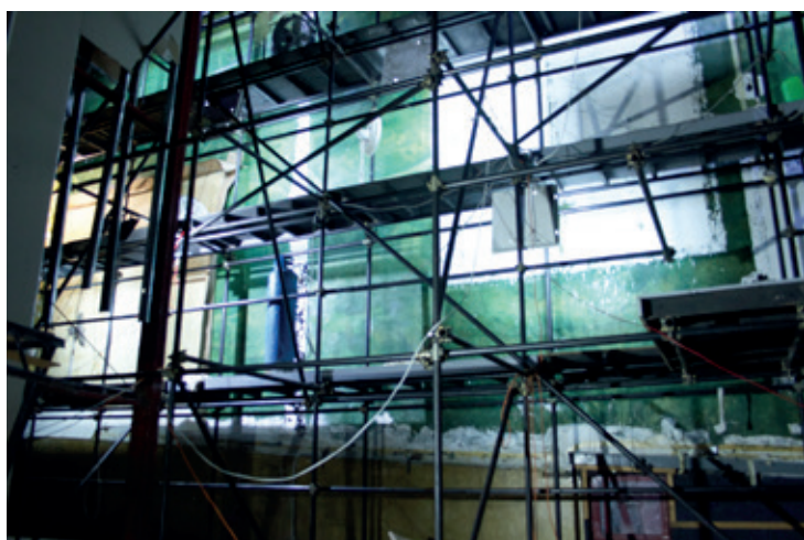
Figura 30 y 31 Murales preparados para ser desprendidos. Fotografía: Mercedes Sierra Kehoe
