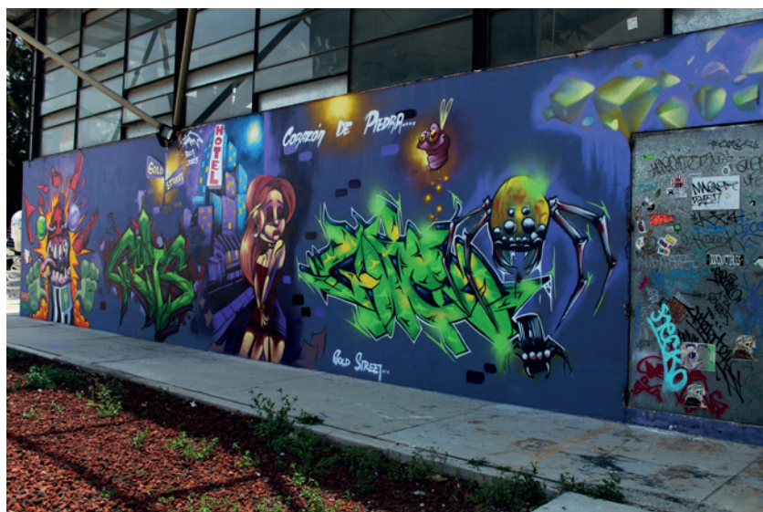
Imagen 40 Nave industrial, muro oriente, detalle de la primera sección. Fotografía: Moisés Falcon, abril de 2023
